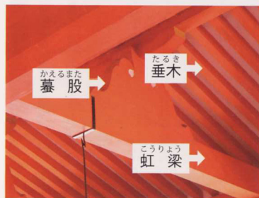
山形の垂木が並ぶ、客神社拜殿天井部
