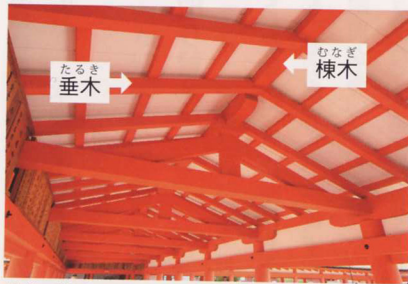
垂木が棟木の下にある回廊天井部
